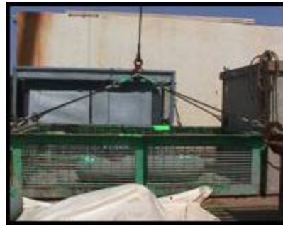
Canasta de carga similar con ángulo de eslinga incorrecto.
